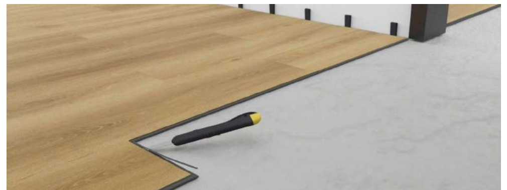
Corte el borde de las ranuras de las tablas adyacentes. / Cut off the lip on the groove of the adjacent planks.
